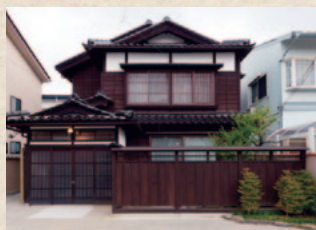
S邸改修後 外観
