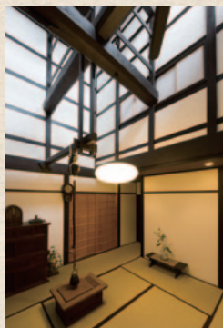
I邸改修後 内観吹き抜け
